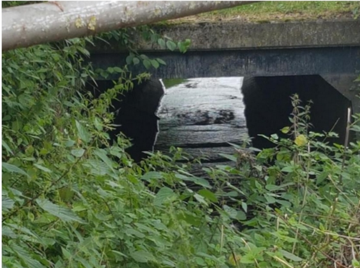
Abb.3: Beispiel einer als „Verrohrung“ gewerteten Unterführung
